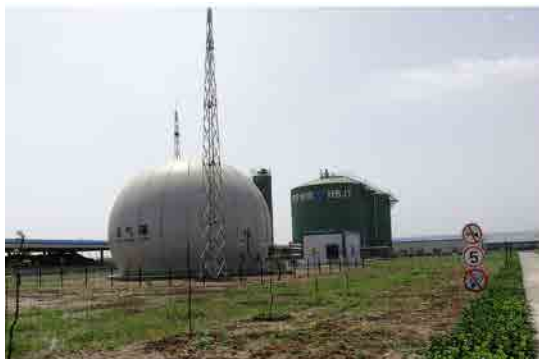
河北示范项目工程
